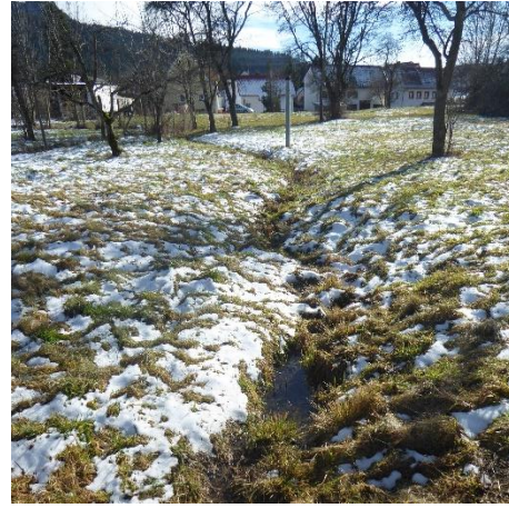
Foto 2: Graben mittig im Plangebiet
