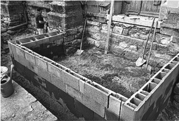
*Beton-Schalensteine bilden den äußeren Kranz des Fundaments*
