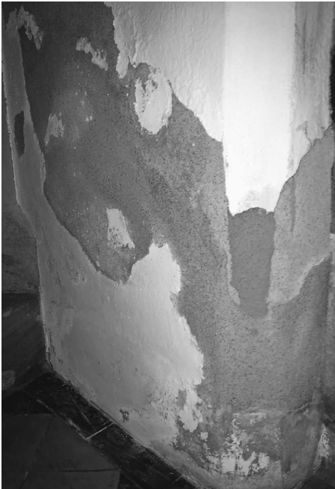
Putz- und Mauerschäden im Eingangsbereich
