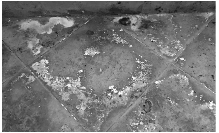
Ausblühungen der Kalksteinplatten
